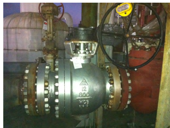
图3 AFA的C型耐磨球阀在宁波万华高温热水泵入口上的应用
