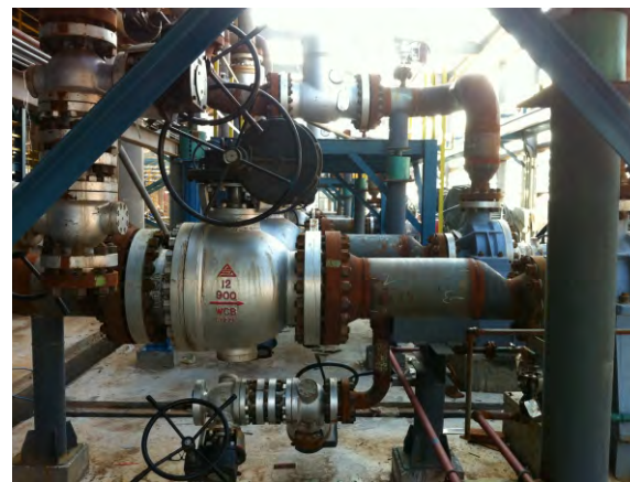
图2 AFA的C型耐磨球阀在金诚泰激冷水泵上的应用
