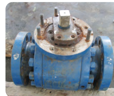
兖矿国泰黑灰水维修
