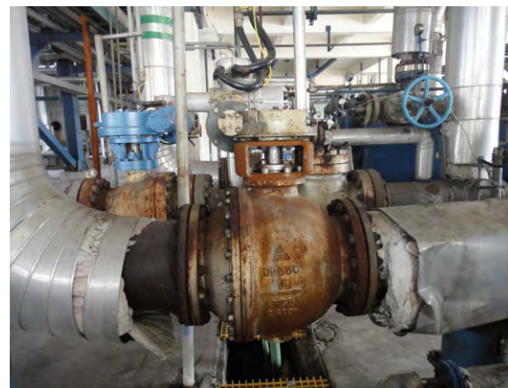
图1 AFA的C型耐磨球阀在新能凤凰低压回水泵上的应用
